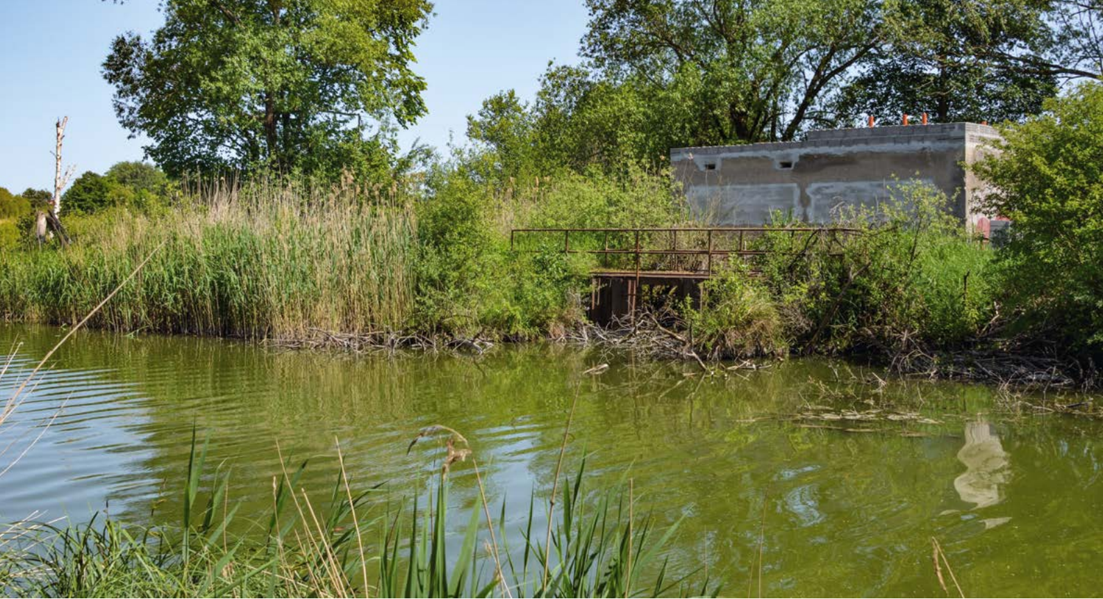
Abseits des Weges liegt das neue Fledermausquartier.
